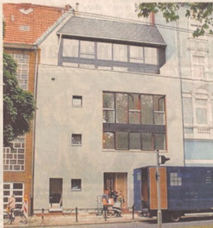
Fünf mal fünf Meter misst das Fenster über zwei Geschosse , das auch Licht ins Erdgeschoss bringt.
