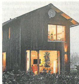
Aus Süddeutschland ein Gebäude im Holzrahmenbau.
